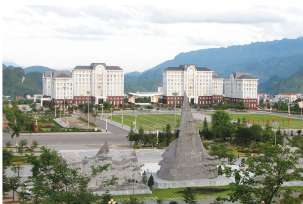
Toàn cảnh Trung tâm Hành chính chính trị tỉnh Lai Châu
