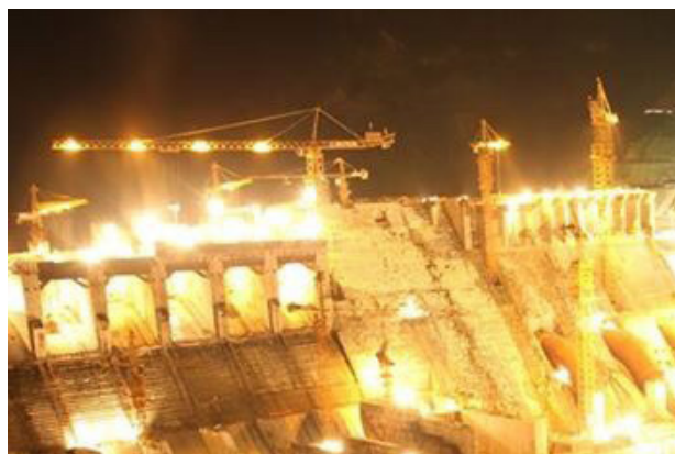
Công trình thủy điện Lai Châu
