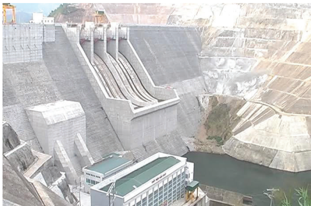
Nhà máy thủy điện Bản Chát
