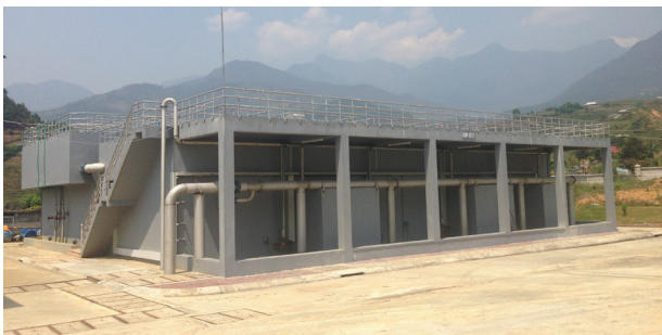
Nhà máy lọc nước Lai Châu
