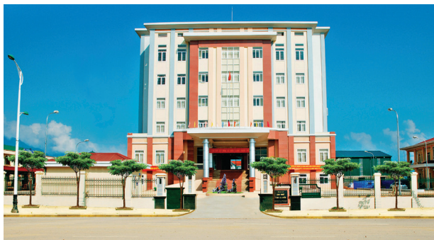
Trụ sở cục thuế tỉnh Lai Châu
